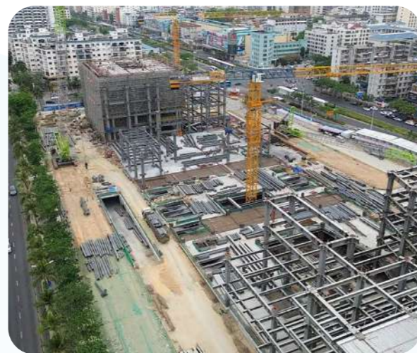
三亚合联中央商务区主体结构建设
